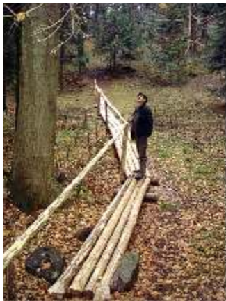
Zdj.6. Drewniana kładka na trasie.
